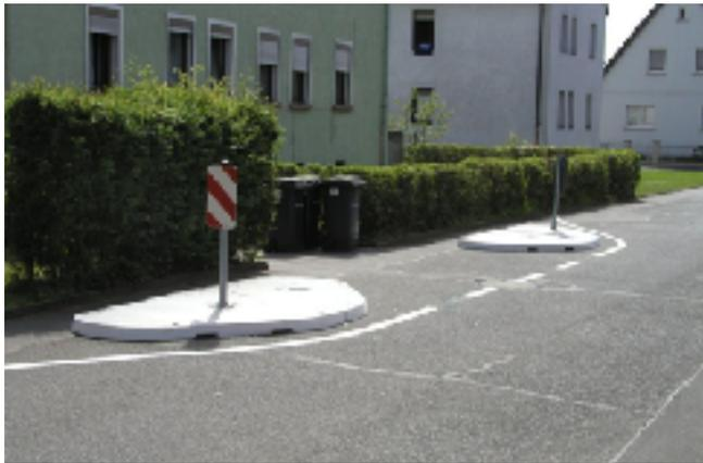
Einfache Querungshilfe mit Fertigelementen
